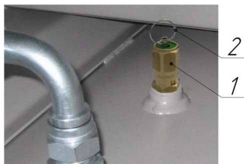
Рисунок 10 – Клапан предохранительный пружинного типа
